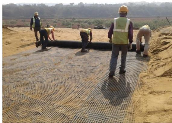
Fig. 7 – Geogrid layingover sand layer
